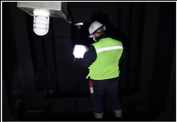
위 치 거더 내부
