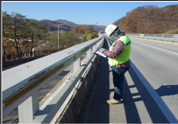
위 치 SLAB 상면
